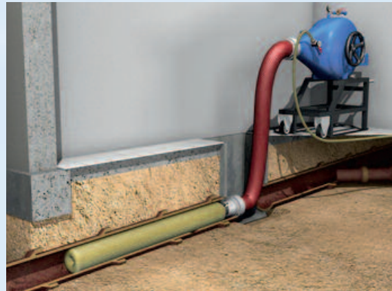
Inliner-Verfahren im Einsatz
